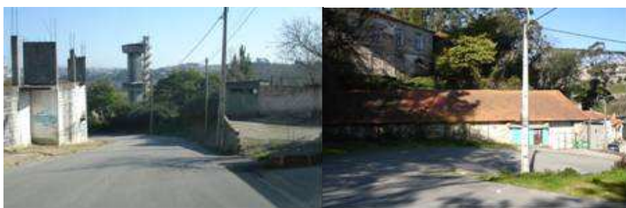
Acesso ao Cais de Quebrantões. É visível o estado de degradação das habitações e armazéns e outros edifícios industriais.
