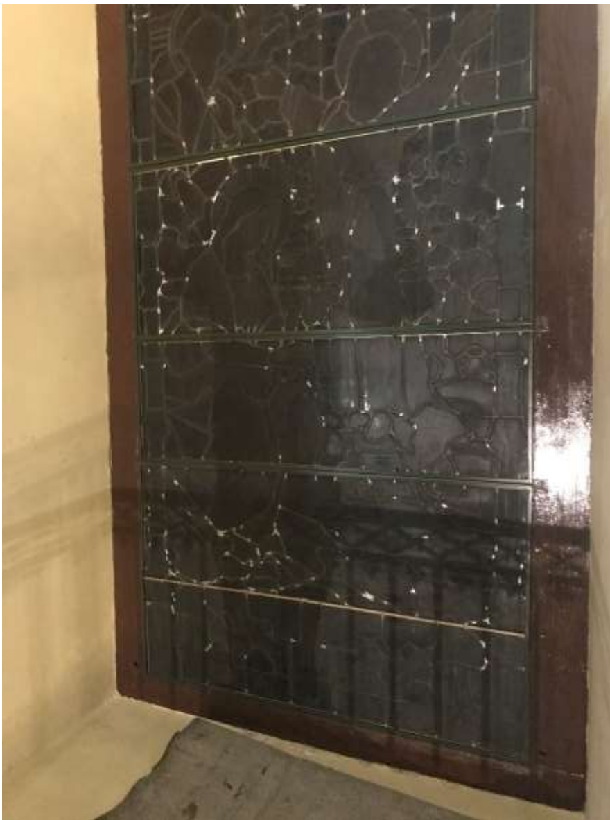
Fig.8- Vitral totalmente colocado e pintura da moldura finalizada
