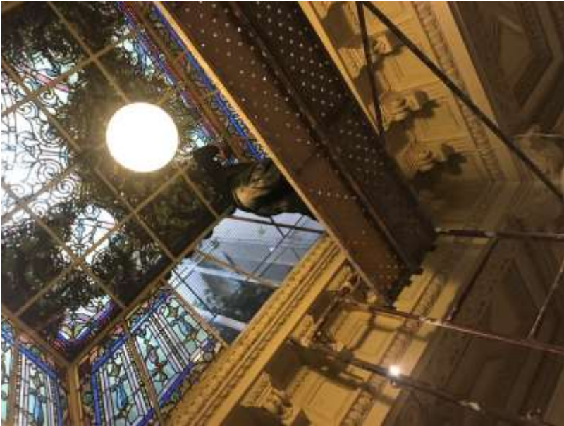
Fig.3- Remoção dos painéis
