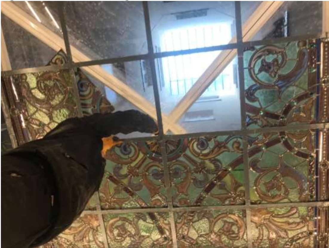
Fig.17- Continuação da montagem
