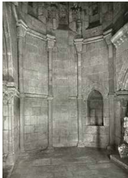
Fig. 73 – Capela de S. João Batista, anexa ao claustro da Sé.
