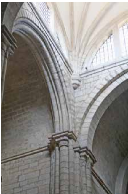
Fig. 71 – Angulo do cruzeiro da catedral, onde arrancam os arcos torais do transepto e da nave central (1ª e 3ª fases).
