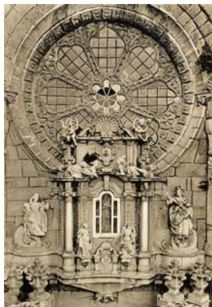
Fig. 66 – O balcão da rosácea da Sé, antes dos restauros da DGEMN.
