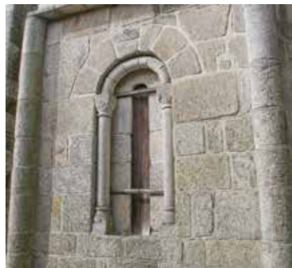
Fig. 16 – Fresta no exterior da capela de S. Pedro.
