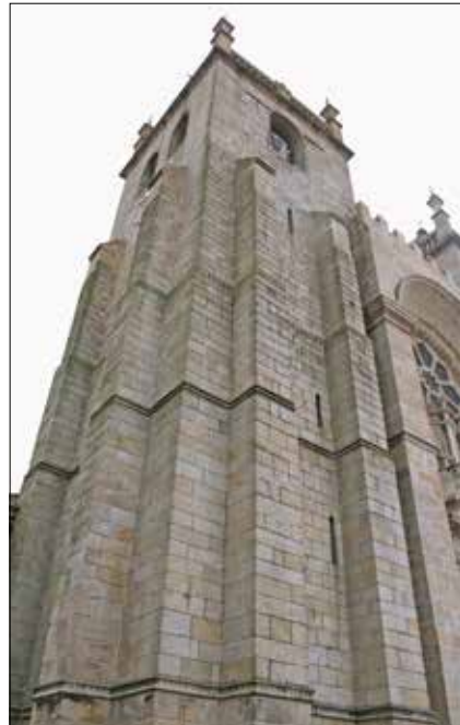
Fig. 60 – Torre setentrional, concluída pelo 3º mestre.
