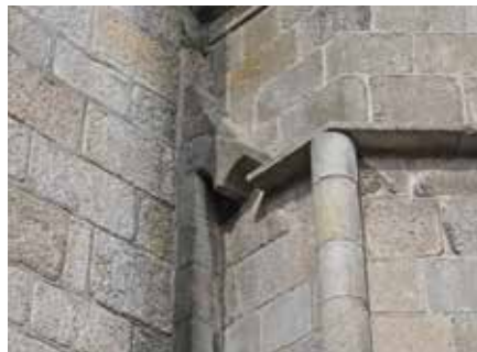
Fig. 34 – Fragmento da primitiva cornija de arcos, na capela de S. Pedro, interrompida pelo lacrimal retilíneo da época moderna.
