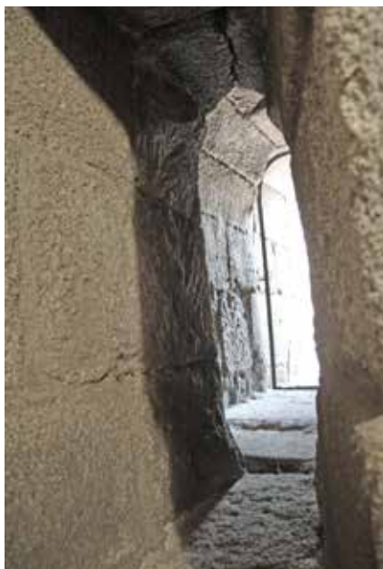
Fig. 61 – Fresta da torre N, com o testemunho da duplicação de muros feita em 1719.
