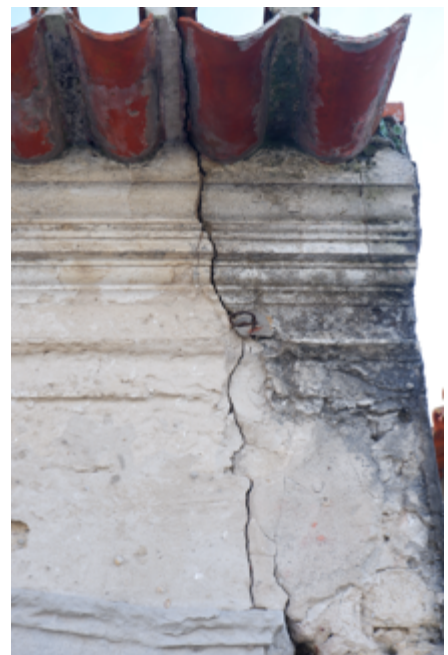
Pano de fachada e friso com falta de coesão das camadas de pintura. No cunhal verificam-se manchas de humidade, fenda e perda de aderência da argamassa.
