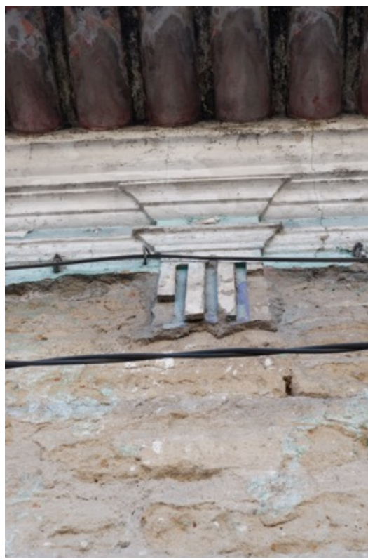
Elemento decorativo onde é possível observar fissuras e perda de coesão das camadas de pintura. Elemento decorativo com perda de aderência das camadas de argamassa.
