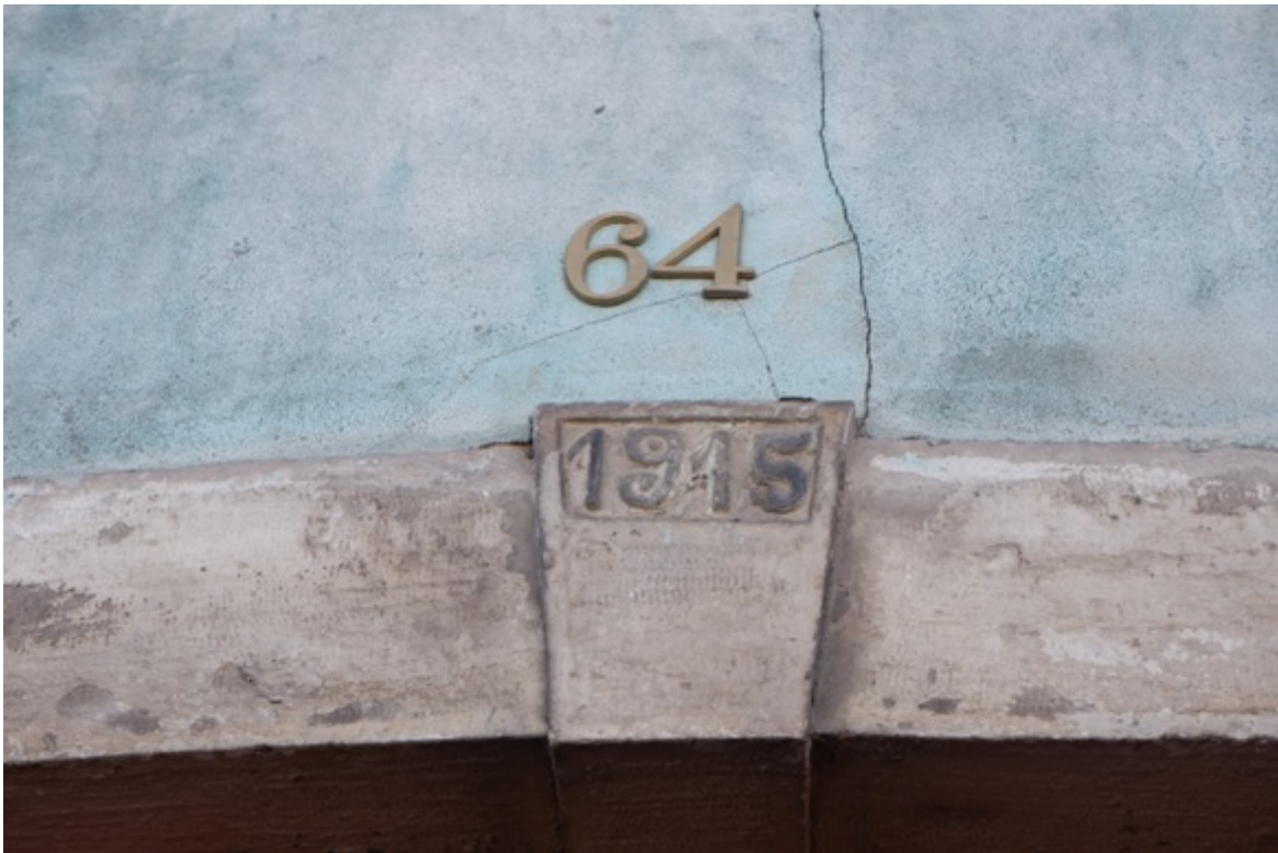
Pormenor da Era com data de construção.
