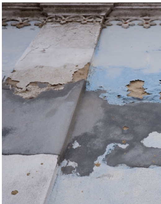
Figura 46 Pormenor de argamassa de cimento aplicada na pilastra e fachada para colmatar danos ©Inês Barreira
