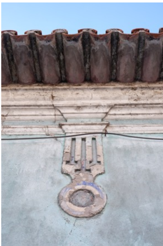
Elemento decorativo onde é possível observar fissuras e perda de coesão das camadas de pintura. Elemento decorativo com perda de aderência das camadas de argamassa.
