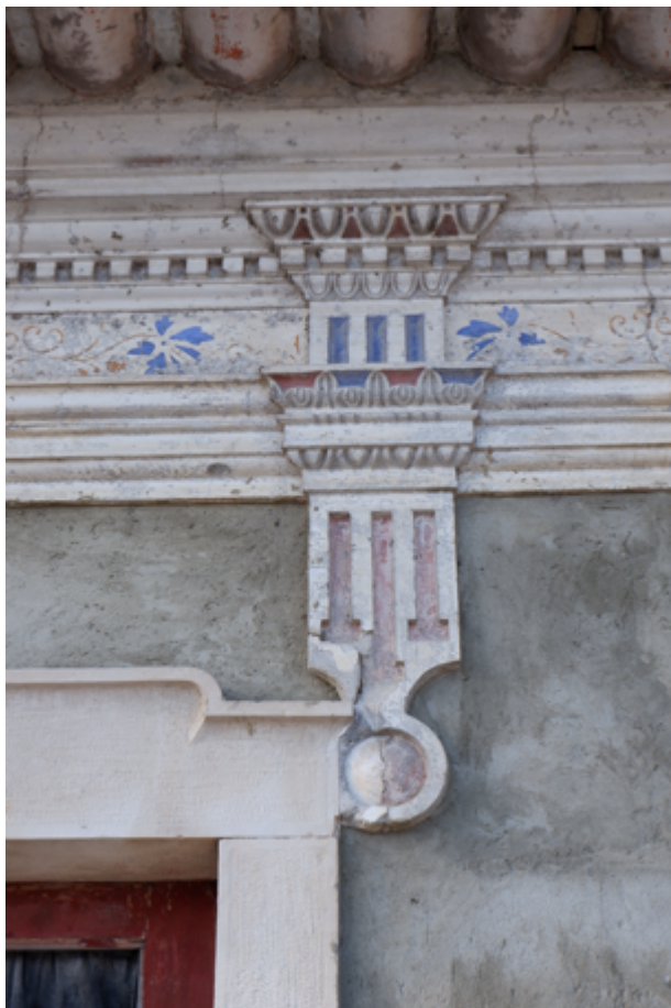
Friso pintado e elementos decorativos. Apresentam argamassa de cimento no pano de fachada, fissuras e manchas de humidade no reboco decorativo.
