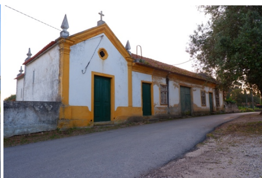
Figura 10 Tipologia porta(capela)-porta-janela- portão-janela-porta-janela. Largo da Capela Velha, Lavandeira ©Inês Barreira
