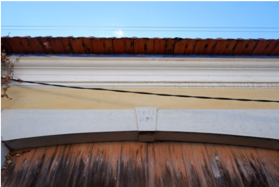
Era Pormenor da cantaria do portão que apresenta a superfície deteriorada pela biodeterioração, com fungos e biofilmes.
