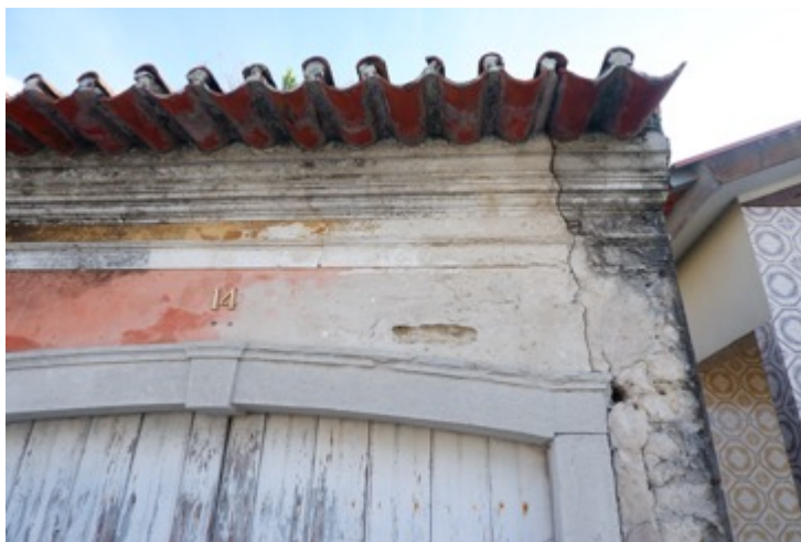
Pano de fachada e friso com falta de coesão das camadas de pintura. No cunhal verificam-se manchas de humidade, fenda e perda de aderência da argamassa.
