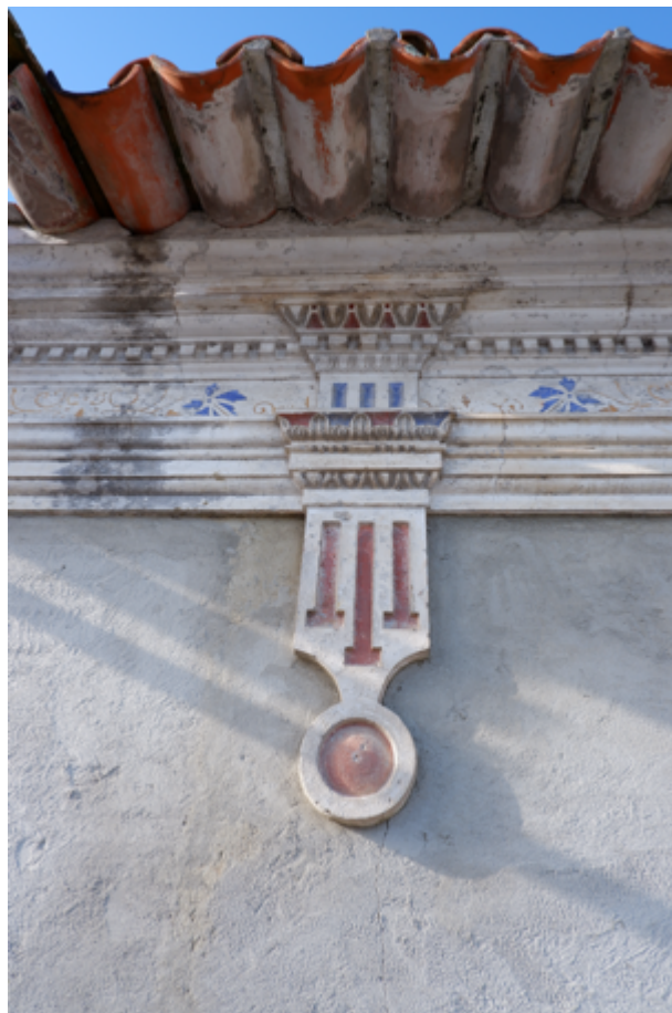
Friso pintado e elementos decorativos. Apresentam argamassa de cimento no pano de fachada, fissuras e manchas de humidade no reboco decorativo.
