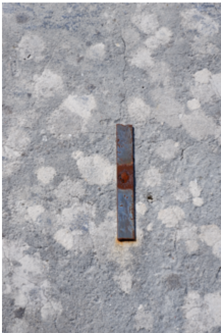
Pormenor de amarração metálica vertical
