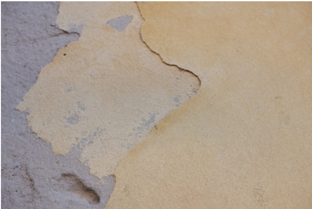
Cunhal com perda de aderência da camada de pintura. Pano de fachada com perda de coesão da camada de pintura.
