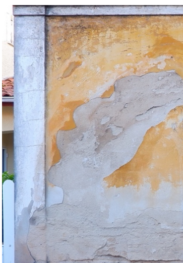
Figura 23 Combinação de cores: amarelo e branco. Cunhal feito em cal. Casa na freguesia de Sosa ©Inês Barreira
